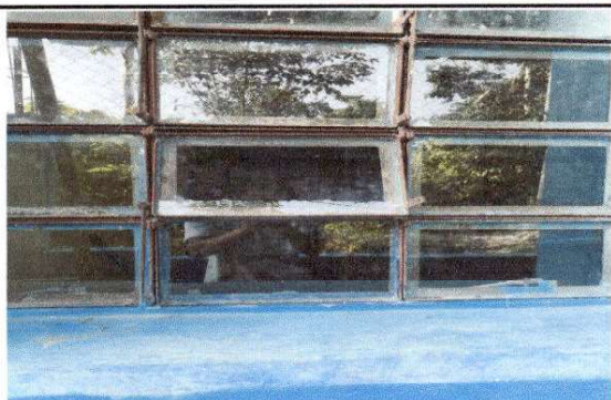
Foto 3: Sustitución de vidrios
