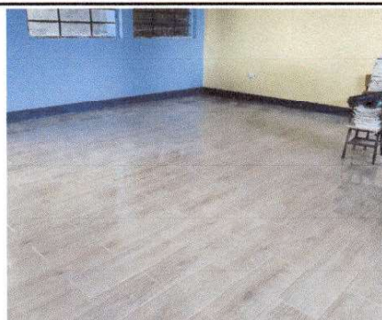
Foto 4: Sustitución de piso de cemento liquido por piso cerámico.
