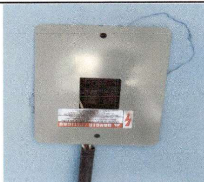
Foto 9: Sustitución de tablero de flipones, flipones, tomacorrientes dobles.
