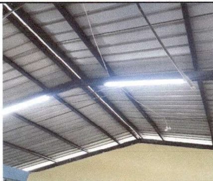
Foto 8: Sustitución de lámparas tipo LED, sustitución de interruptores simples, sustitución de interruptores dobles.
