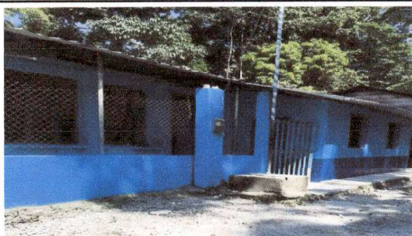
Foto 5: Pintura en muros exteriores.
