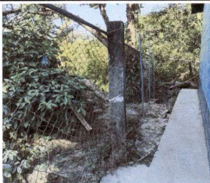
Foto 7: Reparación de tubo HG.
