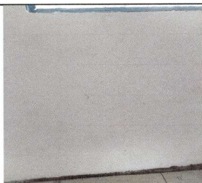
Foto 11: Reparación de repello y cernido de paredes.
